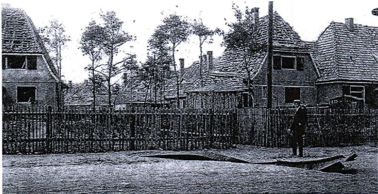
Fast alle Dächer in der erst kürzlich errichteten Kolonie wurden abgedeckt. Fenster und Türen zerbarsten durch den enormen Druck der Explosion.
